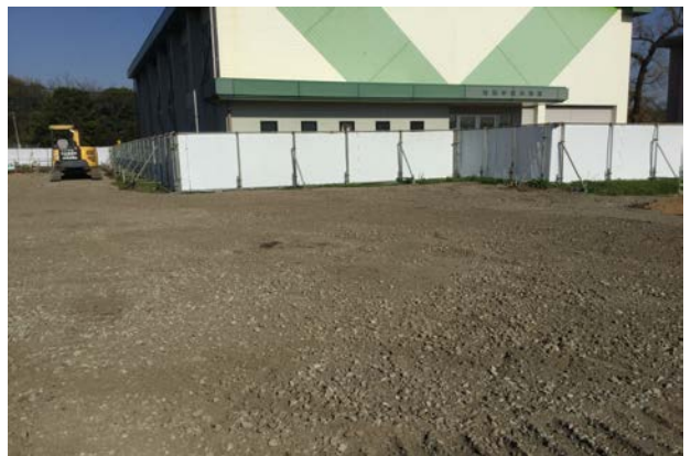
再生砕石の利用状況
