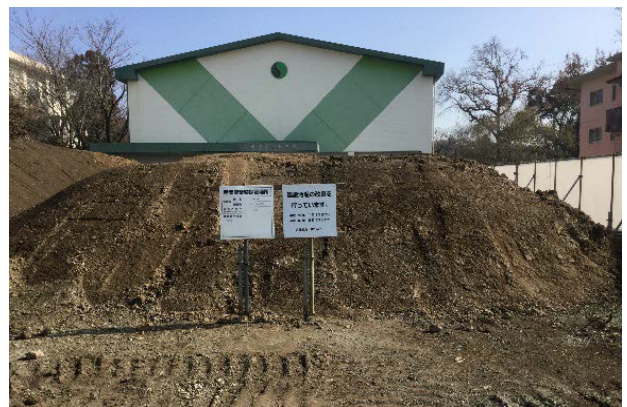
建設汚泥処理土の乾燥・養生
