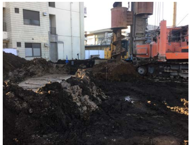
建設汚泥の発生
